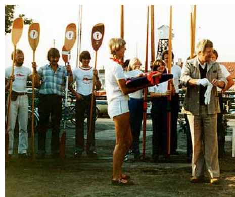
Borgmesteren gør klar til første spadestik til den nye bad- og omklædningsrumsbygning.
